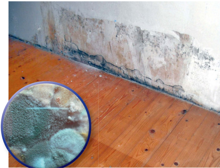
So schaut es aus, wenn sich Schimmelpilz an den Wänden breit macht (großes Bild). Im kleinen Foto ist eine Laborprobe zu sehen.
